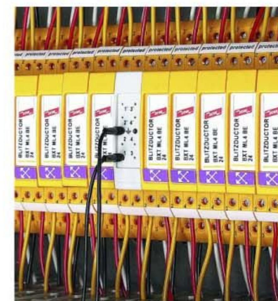
Дополнительный шнур для проверочных / разделительных модулей.
